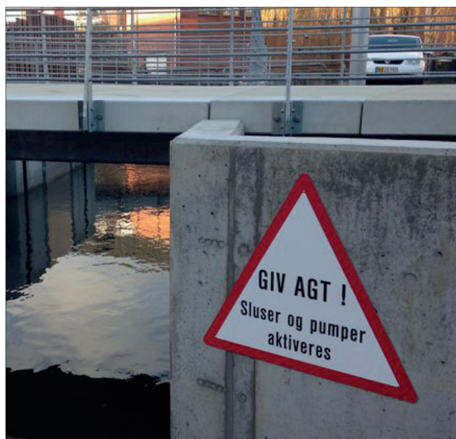
Sluse ved Omløbsåen
