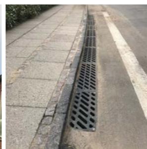
Rist i vestlig vejside Moldevej til opsamling af klimavand på Moldevej. Fra risten løber vandet på ledningen under klimarenden.
